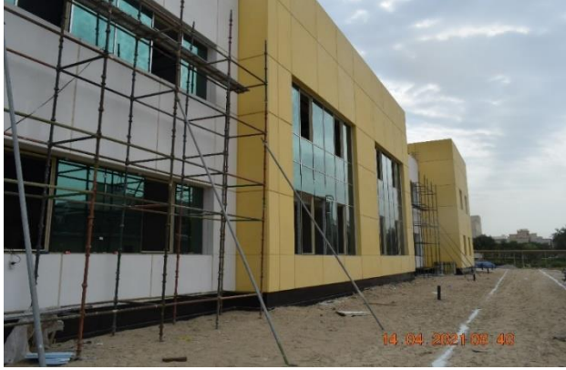
مبنى B في كلية البنين
