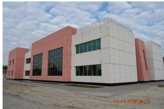
مبنى A في كلية البنات
